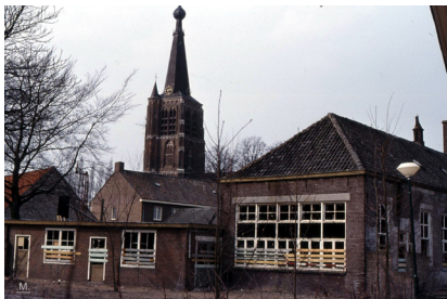
foto 55 Julianastraat, het huis van aannemer Frans van Eert, later "De Huiskamer van zc Graaggedaan". Het kloostergebouw is klaar voor de sloop en voor de bouw van gemeen- schapshuis de Meent. Op de achtergrond de kledingwinkel van Wim Maas, Wilma.
